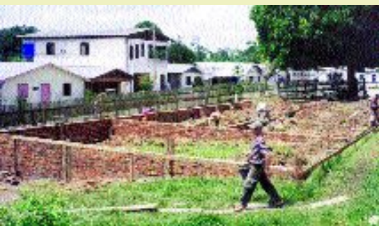
Cimientos del Centro Pastoral de Canutama, construido con ayuda de Wembley.
